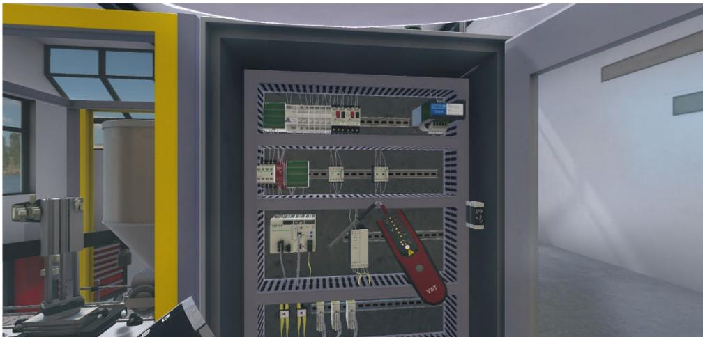
Il pourra ensuite vérifier l'absence de tension en aval de Q1 en testant entre le neutre (première borne en bas de Q1) et chacune des trois phases (les autres bornes à sa droite), puis entre les bornes des phases 2 à 2.
