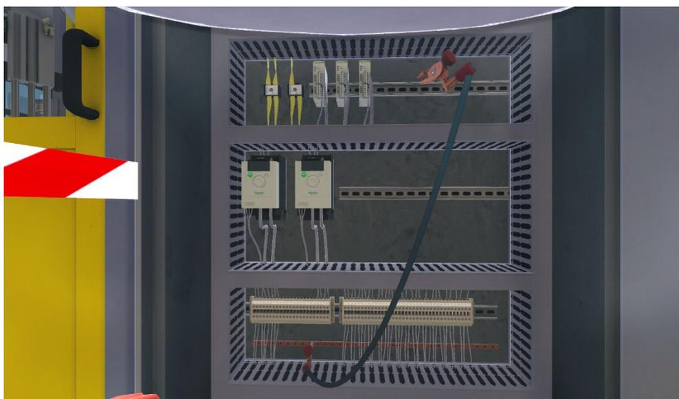
Il faut ensuite fixer une par une 4 pinces sur les 3 phases et le neutre du bornier préalablement ouvert.
