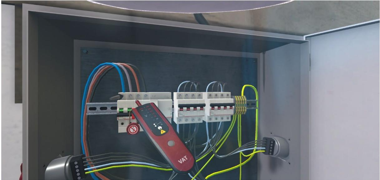
Il pourra ensuite vérifier l'absence de tension en aval en testant entre le neutre (fil bleu) et chacune des trois phases (les autres fils), puis entre les phases 2 à 2.
