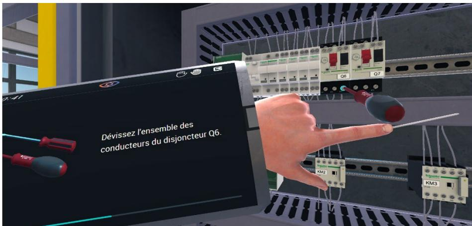
Une fois les conducteurs déconnectés, il peut procéder au remplacement de Q6. Pour ce faire il peut saisir le disjoncteur Q6 défectueux et le ranger dans sa boîte à outils. Il peut alors placer le disjoncteur Q6 neuf au même emplacement dans l'armoire de la polyprod et revisser les différents conducteurs.
