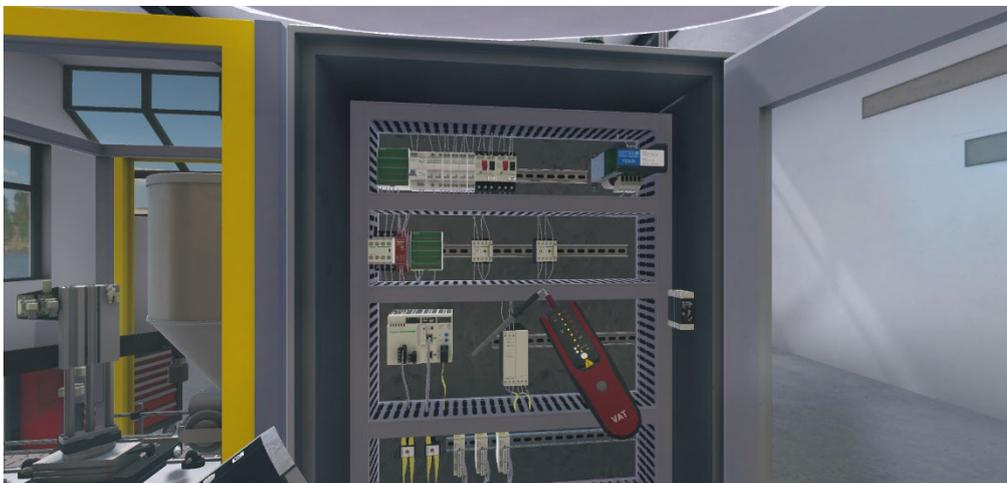
Il pourra ensuite vérifier l'absence de tension en aval de Q1 en testant entre le neutre (première borne en bas de Q1) et chacune des trois phases (les autres bornes à sa droite), puis entre les bornes des phases 2 à 2, c'est-à-dire toutes les combinaisons des quatre bornes du bas deux par deux.
