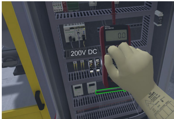
Mesures sur le contacteur KM1 entre les bornes A1 et A2 (609-112)
