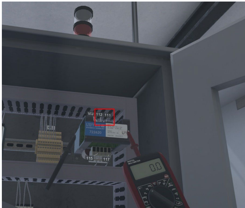
Mesures sur l'alimentation U1 entre les bornes 112-111
