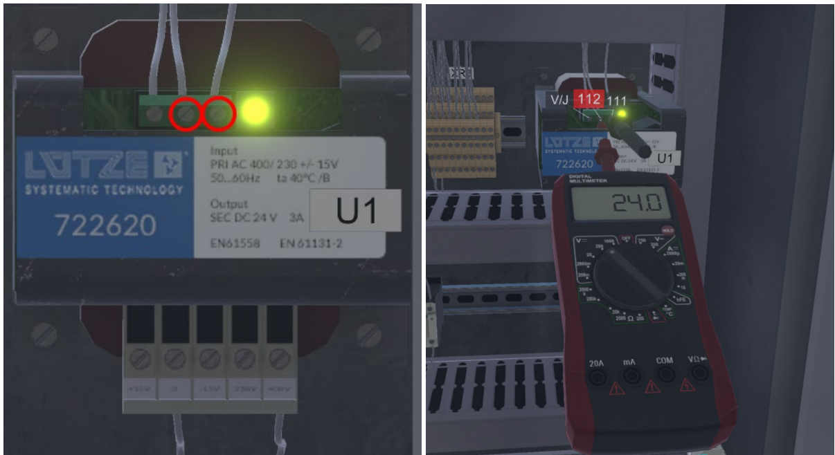
Mesure de tension au niveau de KA1 entre A1 et A2 (respectivement les bornes 602 et 112)
